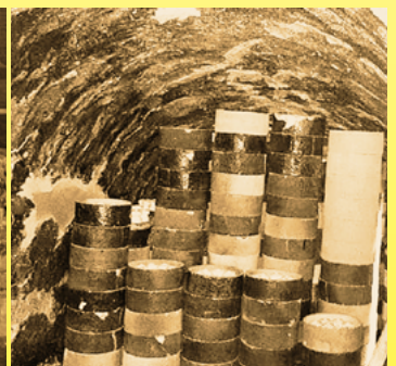
Traditionell chinesischer Drachen-Töpferofen (chinesisch 龙窑 lung-yao). Öffnung zum Beladen und Stapelmethode mit Elektroporzellan (Privatsammlung)
