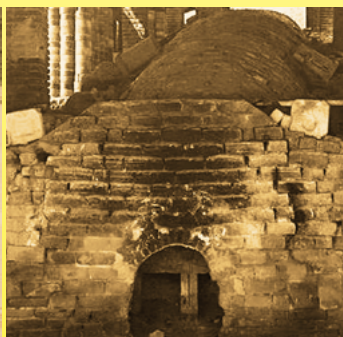
Traditionell chinesischer Drachen-Töpferofen (chinesisch 龙窑 lung-yao). Öffnung zum Beladen und Stapelmethode mit Elektroporzellan (Privatsammlung)
